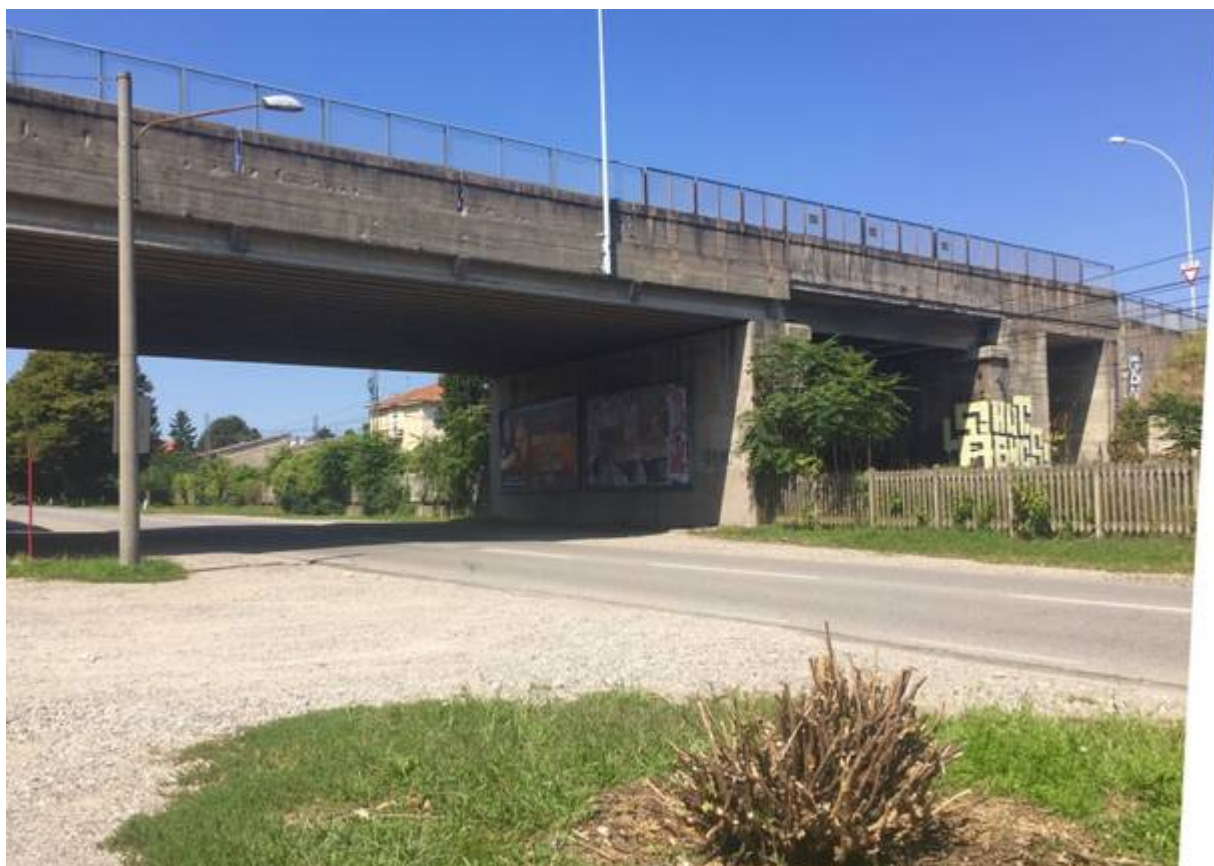
Il ponte che scavalca Statale e ferrovia del Sempione, alla periferia di Gallarate andando verso Somma
